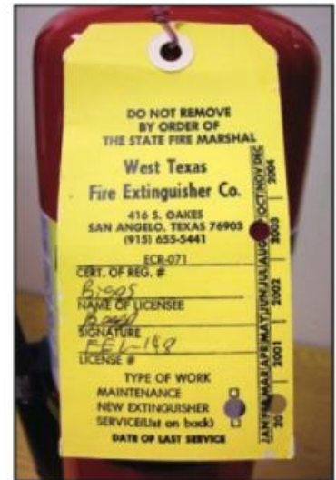
Figura 7.14 Los extintores de incendios deben etiquetarse con su registro de mantenimiento.
