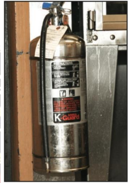
Figure 7.5 Los extintores de Clase K contienen un agente específicamente formulado para contrarrestar los incendios del aceite de cocina. Cortesía de Ron Moore / McKinney (TX) FD.
